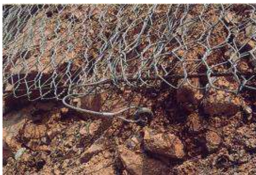
Slika 7. Sidrenje MREŽE na dnu sajlom i klinom s kukom
