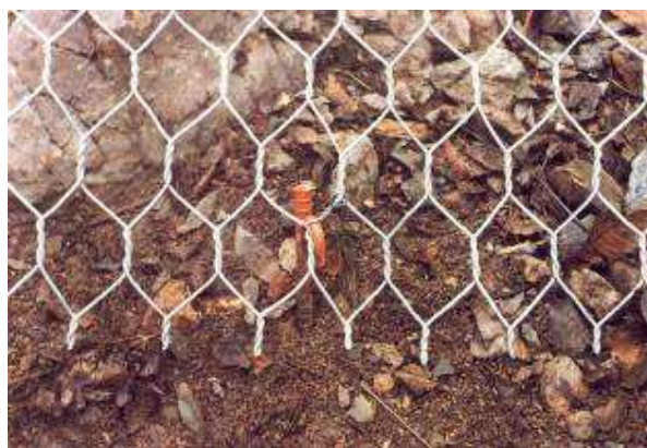
Slika 8. Sidrenje MREŽE na dnu klinom s kukom
