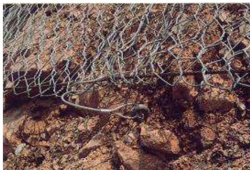
Slika 7. Sidrenje MacMata na dnu sajlom i klinom s kukom
