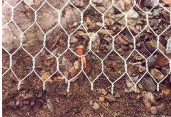
Slika 8. Sidrenje MacMata na dnu klinom s kukom
