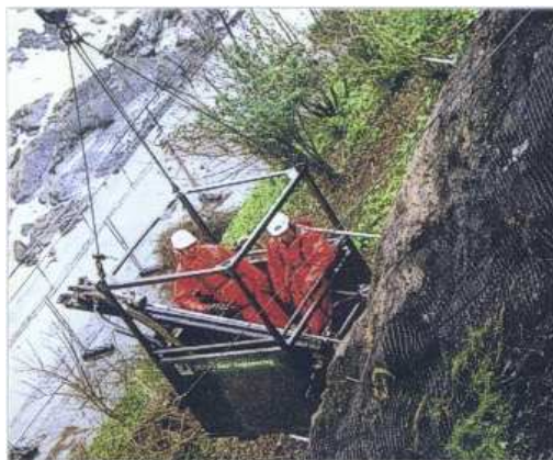
Ovješena radna platforma na ugradnji sidara
