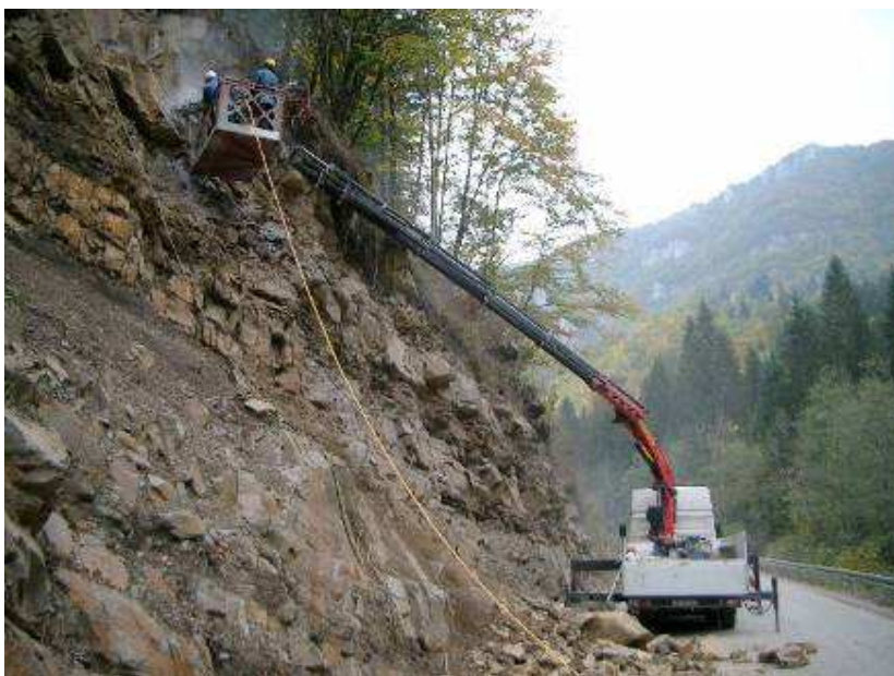
Hidraulička ruka sa platformom i hidrauličkom bušilicom
